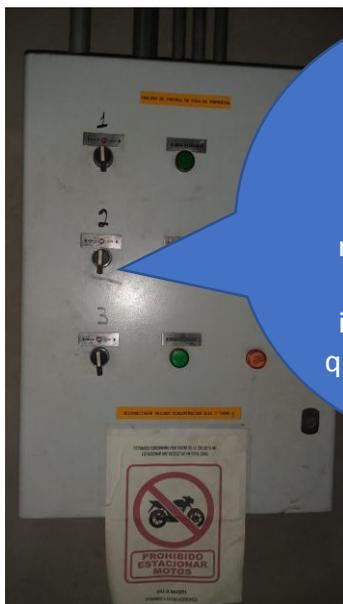
De las 3 bombas existentes, la única que enciende es la bomba #2, sin embargo no está realizando su trabajo de extracción e inyección, en razón a que está desconectada de la tubería
