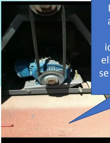
Los extractores estaban apagados, por lo que se ponen en marcha identificando que uno de ellos se encuentra pegado, se realiza el mantenimiento correctivo
